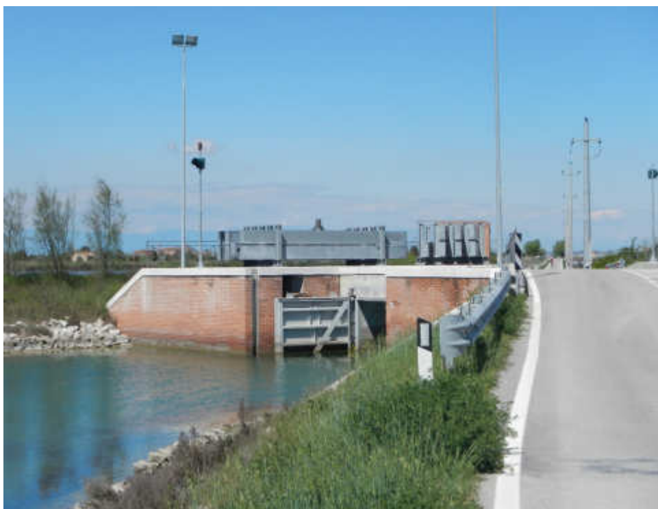
Figura 7-10: Conca idraulica 1 (repertorio fotografico – sopralluogo AGRI.TE.CO. aprile 2012)
