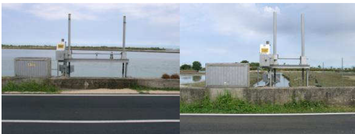
Figura 5-19: Chiaviche ad azionamento automatico lungo il canale Pordelio (Magistrato alle Acque - AGRI.TE.CO, 2005)
