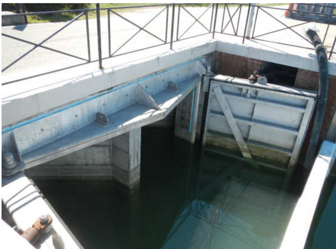
Figura 7-11: conca idraulica 2 (repertorio fotografico – sopralluogo AGRI.TE.CO. aprile 2012)
