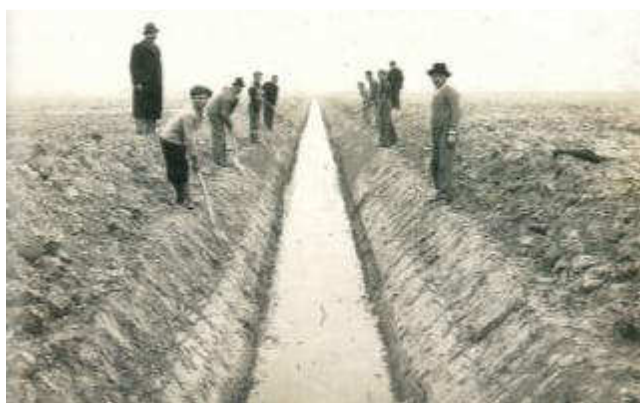
Figura 7-6: Punta Sabbioni. Scavo di un fosso scolmatore nel terreno in concessione a Giovanni Pianta lungo via Hermada, 1938 (Piero Santostefano, 2011: Da ortolani a imprenditori – Trasformazioni del mondo agricolo di Cavallino-Treporti - secc. XVI-XX) (Piero Santostefano, 2011: Da ortolani a imprenditori – Trasformazioni del mondo agricolo di Cavallino-Treporti - secc. XVI-XX)
