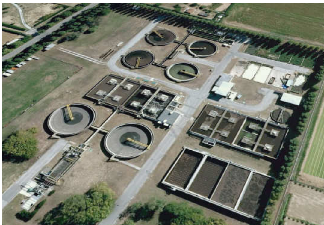
Figura 8-16: Impianto di depurazione di Ca' Pasquali
