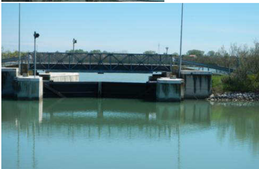
Figura 7-12: Conca idraulica 3 (repertorio fotografico – sopralluogo AGRI.TE.CO. aprile 2012)
