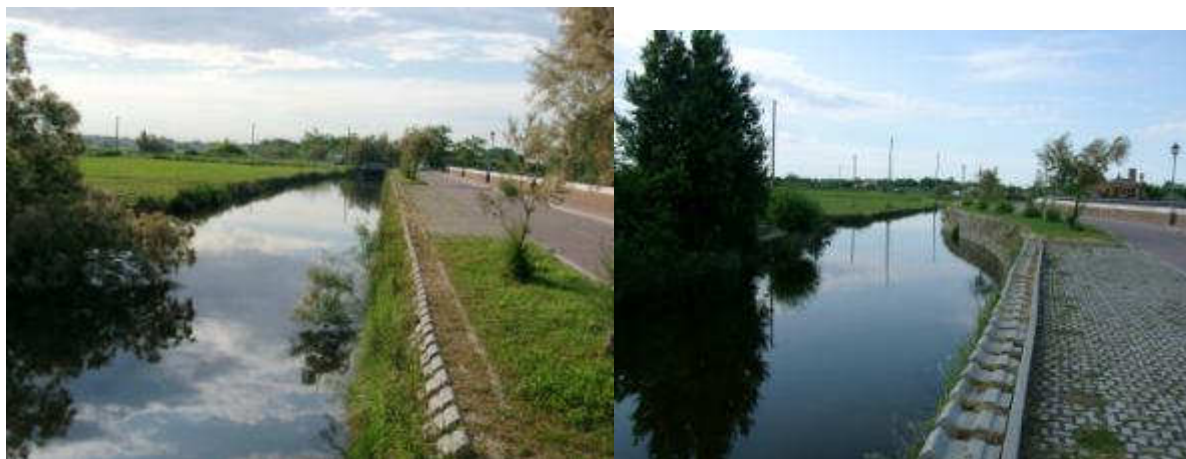
Figura 5-16: Punta Canale Pordelio - particolare della sponda esterna con elementi in calcestruzzo (Magistrato alle Acque - AGRI.TE.CO, 2005)
