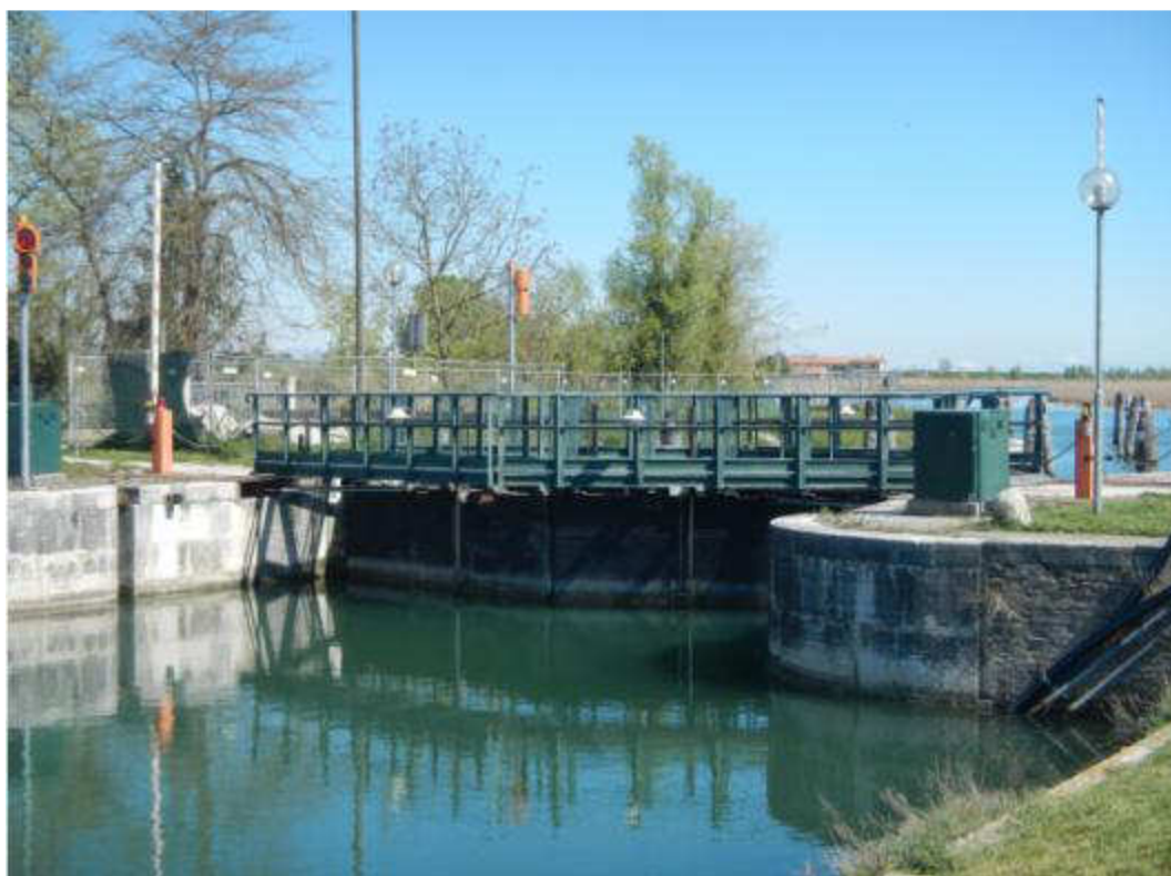
Figura 7-14: Porte vinciane - lato Sile (rilievo fotografico – sopralluogo AGRI.TE.CO. aprile 2012)
