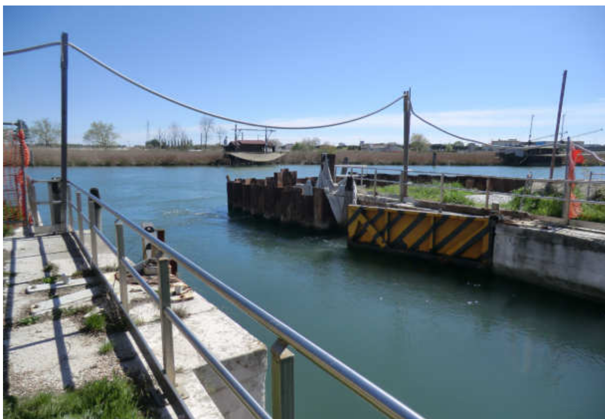
Figura 7-16: Porte vinciane (rilievo fotografico – sopralluogo AGRI.TE.CO. aprile 2012)
