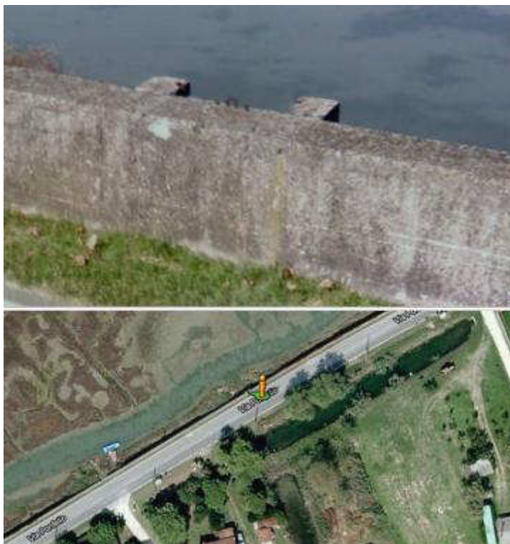
Figura 7-21: Esempio di chiavica eliminate (sopralluogo AGRI.TE.CO aprile 2012)
