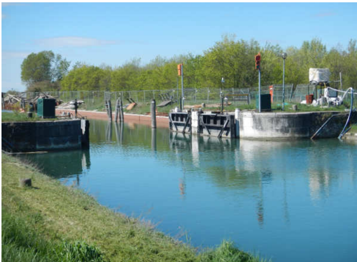
Figura 7-15: Porte vinciane - lato laguna (rilievo fotografico – sopralluogo AGRI.TE.CO. aprile 2012)
