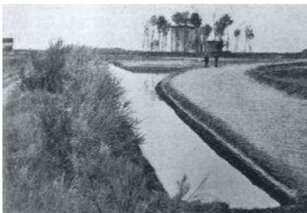
Figura 7-5: Ca' di Valle 1927. Il rilievo stradale della via Fausta in corso di costruzione. Si osservi sullo sfondo uno degli edifici del sistema difensivo militare. (Le Tre Venezie, dicembre 1931, p.32) (Piero Santostefano, 2011: Da ortolani a imprenditori – Trasformazioni del mondo agricolo di Cavallino-Treporti - secc. XVI-XX)
