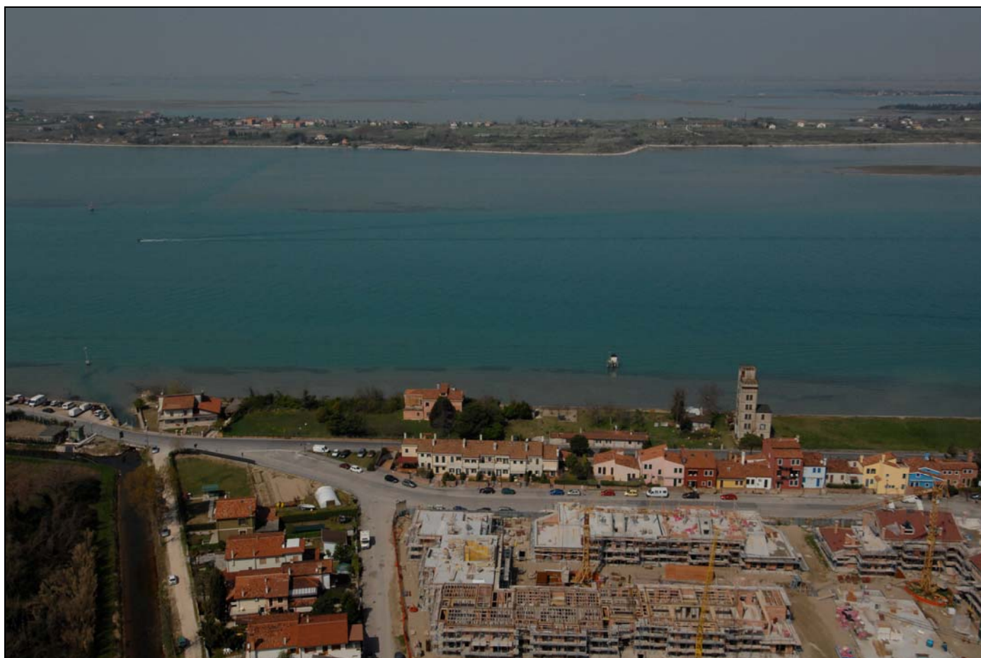
Figura 0-55: Insediamento abitativo e nuovo complesso residenziale in costruzione lungo il Canale di Treporti
