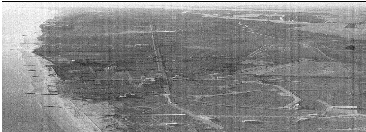
Veduta aerea di Ca' di Valle (dopo la bonifica) e dei primi insediamenti turistici (spazio ora occupato dal camping Joker)
