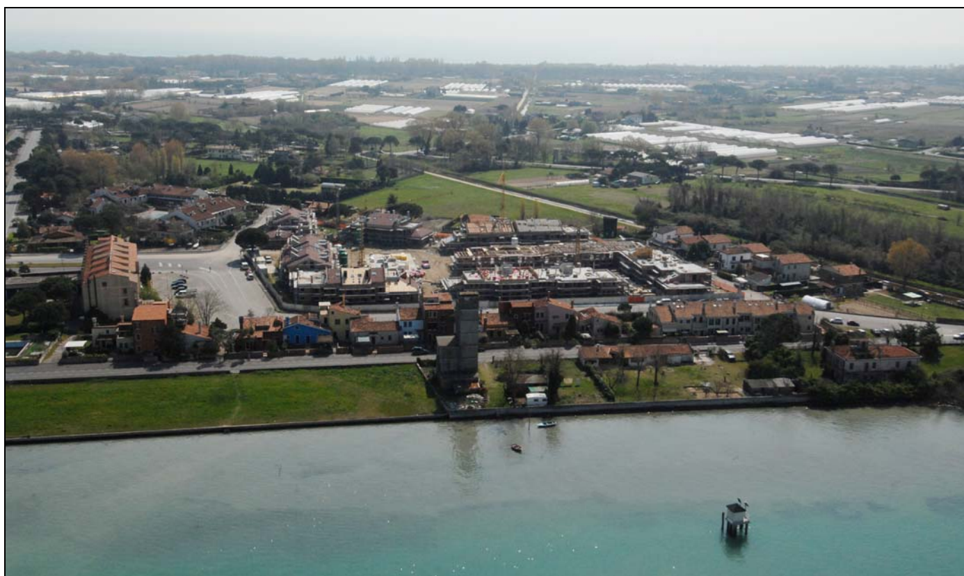
Figura 0-52: Torre telemetria lungo il Canale di Treporti
