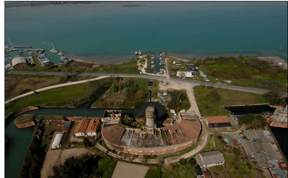
Figura 0-1: Veduta aerea del complesso di Forte Vecchio
