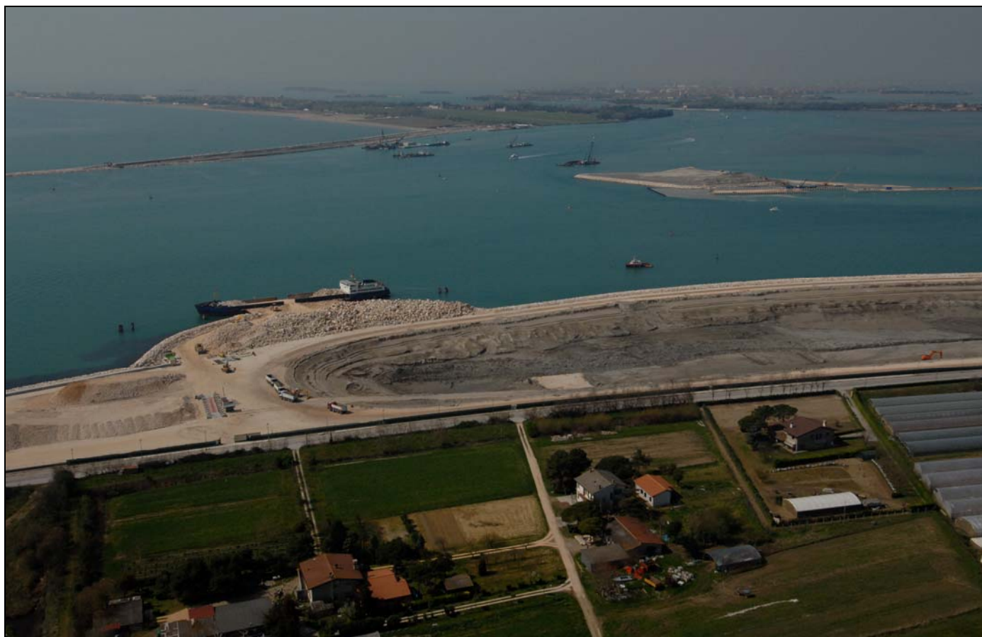
Figura 0-54: Opere del “M.O.S.E.” in via di costruzione presso Punta Sabbioni
